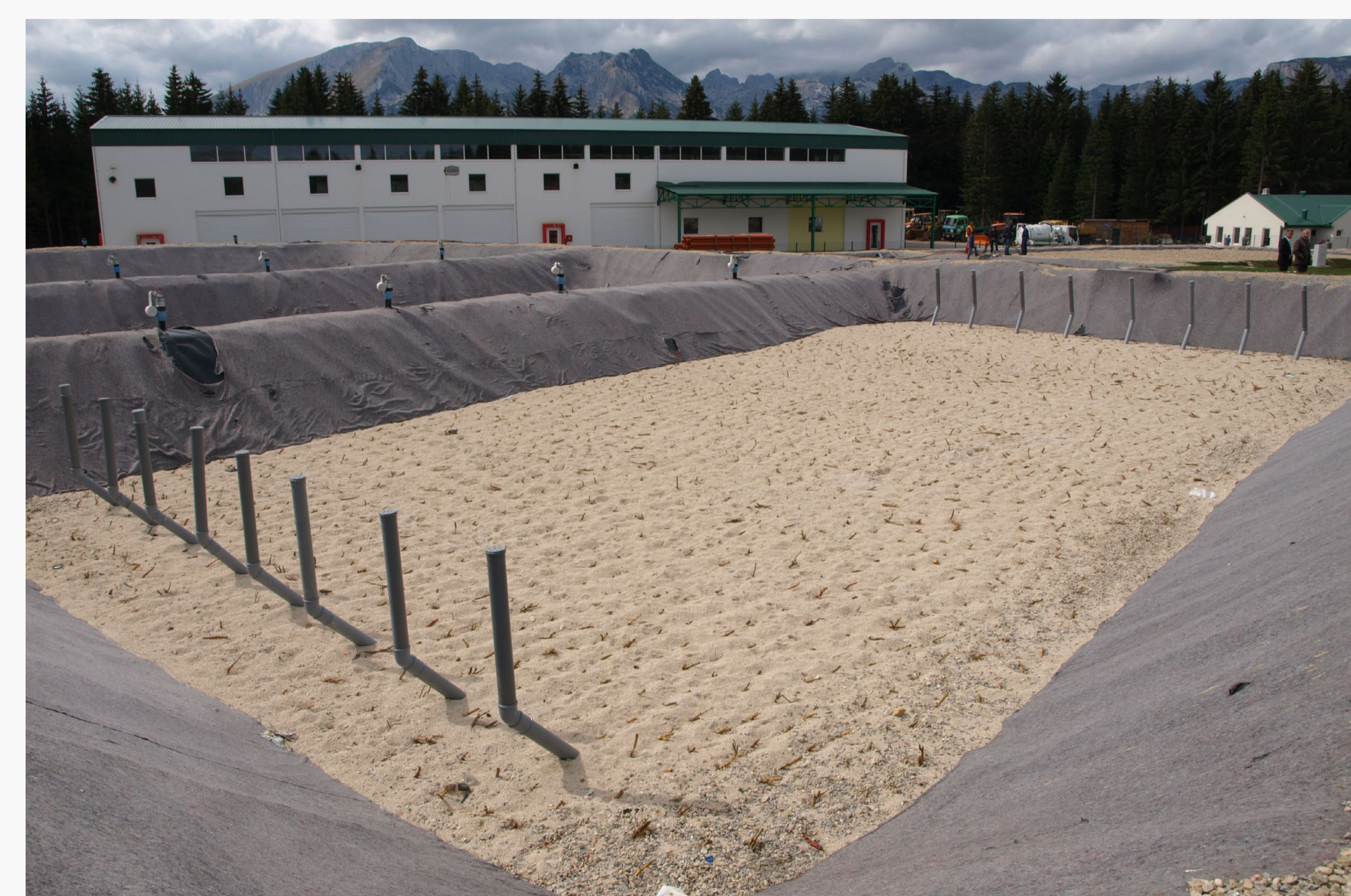
Hala sortirne linije za mešane odpadke in deponija odpadkov z bazeni za tretiranje blata iz čistilnih naprav na Žabljaku v Črni gori.
